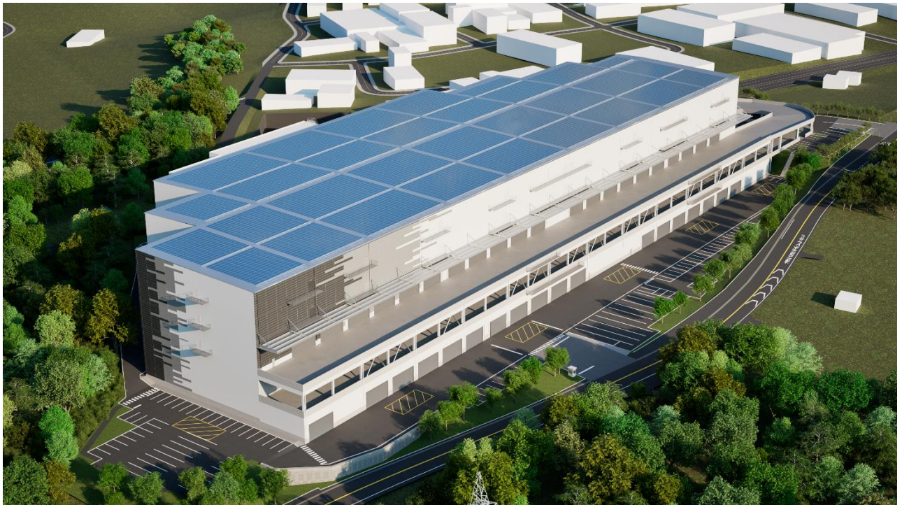
<「(仮称) T-LOGI 相模原」外観>
